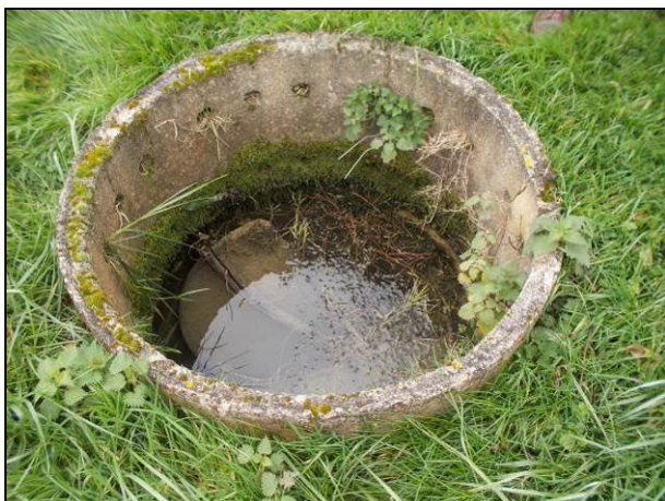
Photo 5 : Regard en aval de la source
