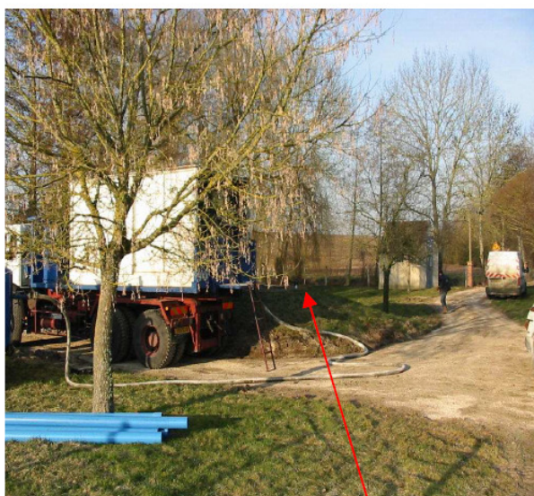
Vue extérieure du captage
